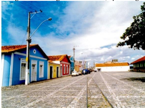
Fotografia 2 – Largo da Rua Chile, após Programa Fachadas da Rua Chile
